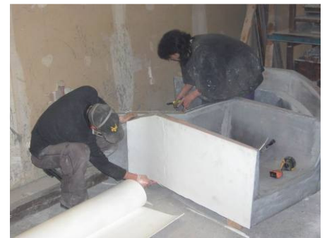
Preparado para Instalación
