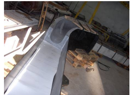
Armado de Sección
